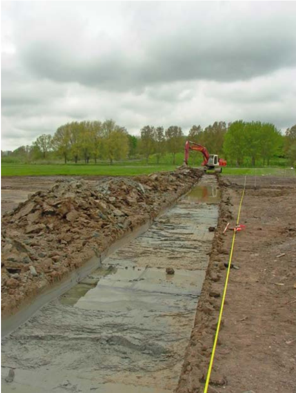
Afbeelding 14 De aanleg van het vlak
